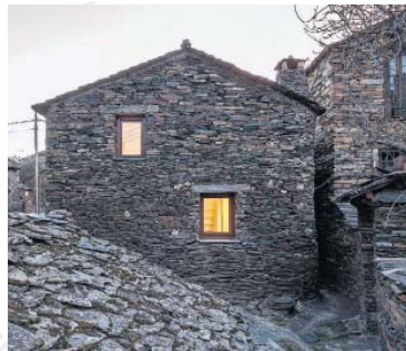
Exterior de pizarra de la edificación rehabilitada, y vista del interior.
